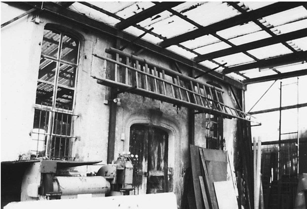
Abb. 4: Eingangsportal der Synagoge
