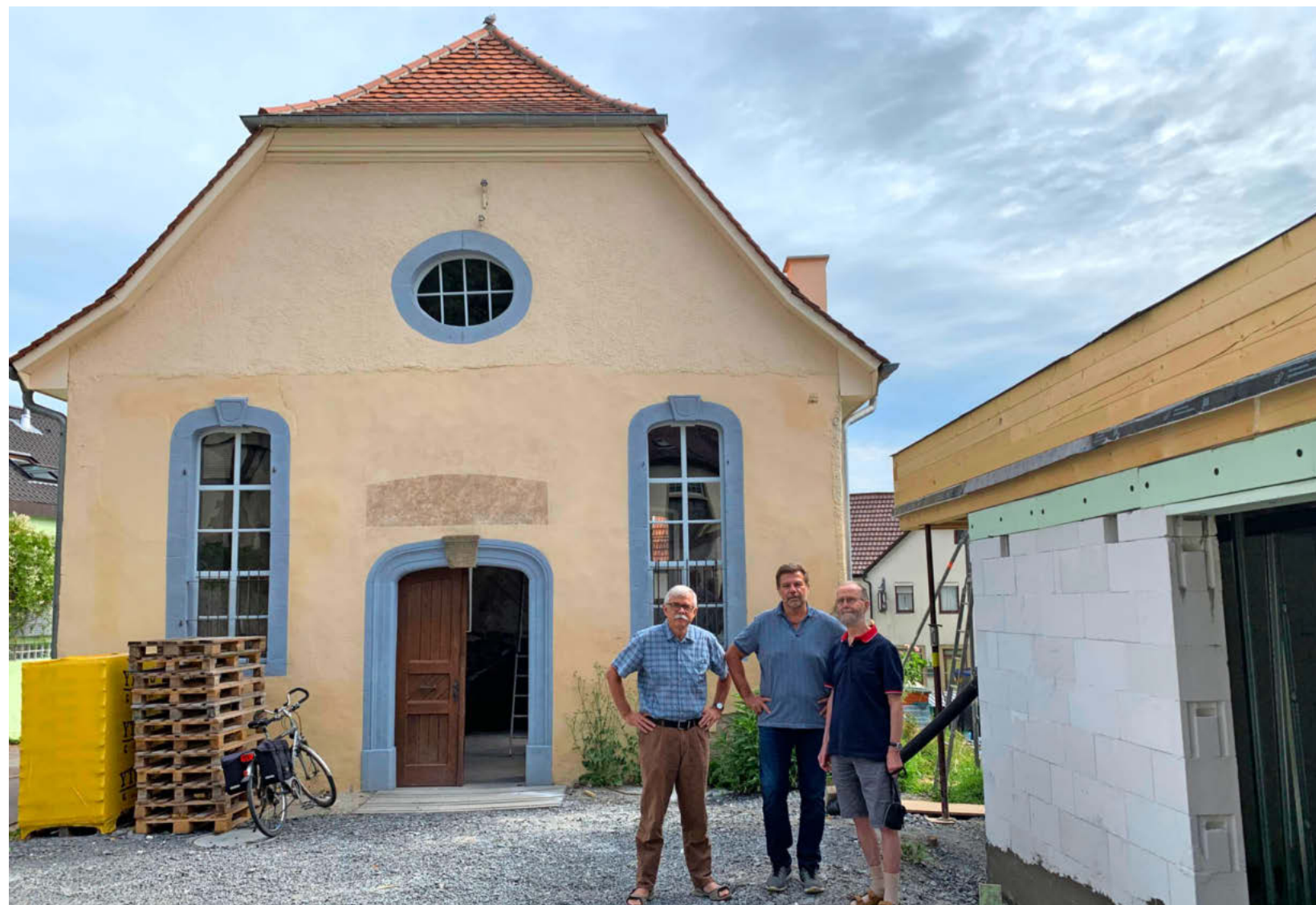
Hans-Eckard Bucher, Manfred Schädler und Bernd Göller (von links) haben die Bauarbeiten an der ehemaligen Synagoge in Heinsheim im Blick.
